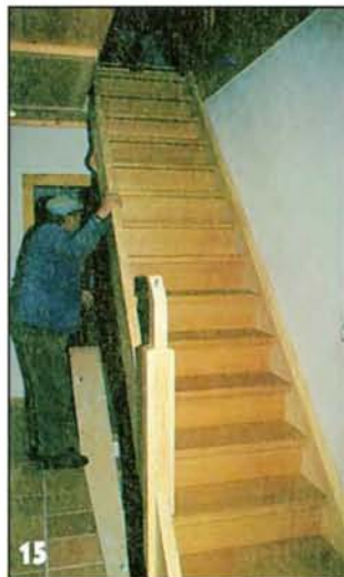
15 Торчащие из свободной тетивы штыри вставляют в отверстия, просверленные в полу. Верхние концы тетив опираются на край проёма.
