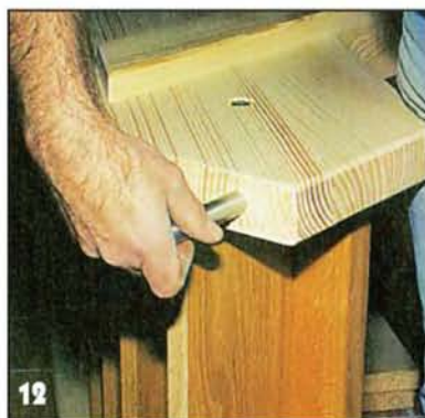
12 Прежде чем установить лестницу, в нижний торец свободной тетивы врезают мощные стальные штыри, исключающие смещение лестницы.
