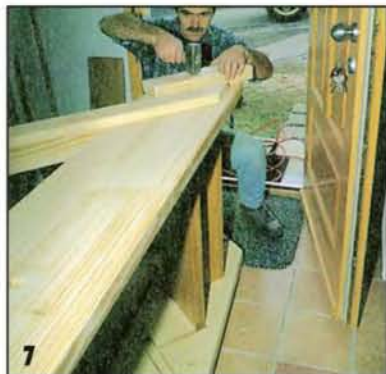
7 Собирают вторую (свободную) тетиву с нижней стойкой перил.
