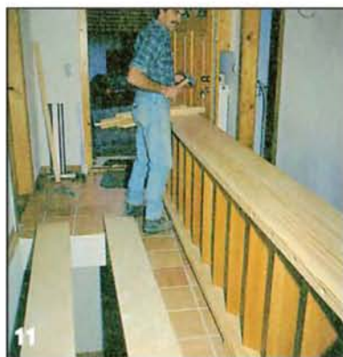
11 Теперь можно снова приладить вторую (свободную) тетиву, закрепив её шурупами.
