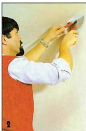
2 Уложенное на слой клея полотнище обоев прижимают к основе обойным шпателем. Края обоев обрезают по кромке шпателя.
