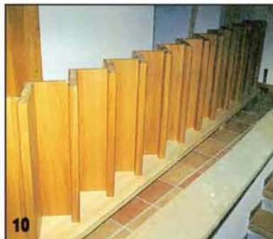
10 Проступи вставляют в пазы тетив, а подступёнки — в пазы, выбранные на нижней стороне проступей, и сбивают гвоздями.
