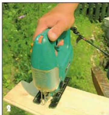
Электролобзиком опилили торцы двух заготовок, чтобы они повторяли лицевой контур блок-хауса.
