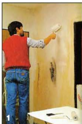
1 При оклейке стен стеклотканевыми обоями клей обильно наносят на основу.
