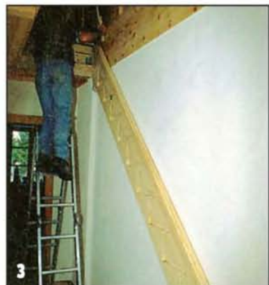
3 Производят сборку лестницы по месту. Для этого сначала ставят настенную тетиву, тщательно выверяя её положение.
