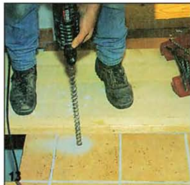
13 Для этих штырей в полу лестничной клетки сверлят два отверстия сначала сверлом меньшего диаметра, затем — сверлом, соответствующим диаметру штырей.
