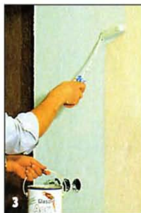
3 Нанесённый на обои тонкий слой разбавленного клея, их с помощью валика покрывают лаком.
