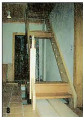
8 Теперь можно добавить две ступени в средней части лестницы. И так, соединив обе тетивы верхними, нижними и средними ступенями (везде — по две), можно проверить качество подгонки лестницы. В этом случае тетивы должны быть взаимно параллельными.
