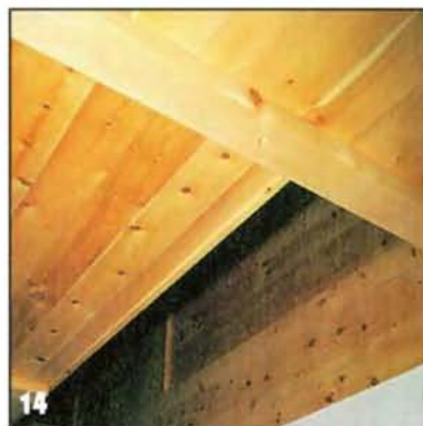
14 После завершения обшивки досками лестничной клетки и проёма можно окончательно устанавливать лестницу.
